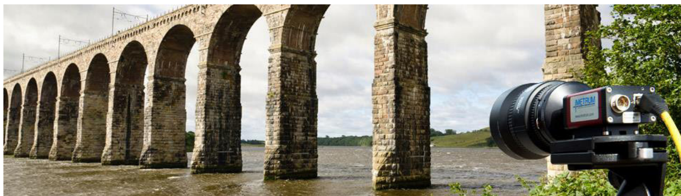
Измерение деформации железнодорожного моста
