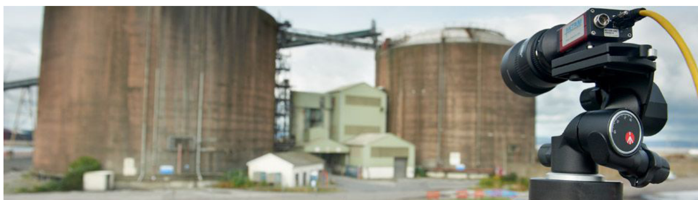
Измерение деформации стенок и основания цистерн
